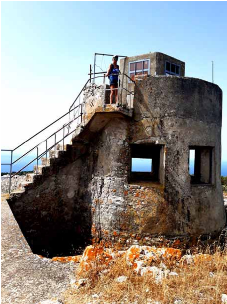
Das steinerne „Gipfelgebäude“ ganz oben
